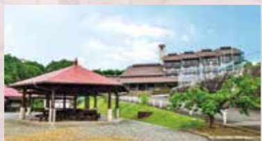
丹嶺学苑研修センターは1981年10月竣工。2016年に大幅な改修工事を行い、同年4月にリニューアルオープンしました。
