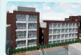
建築中の地下1階、地上5階の新校舎(2022年1月完成予定)
