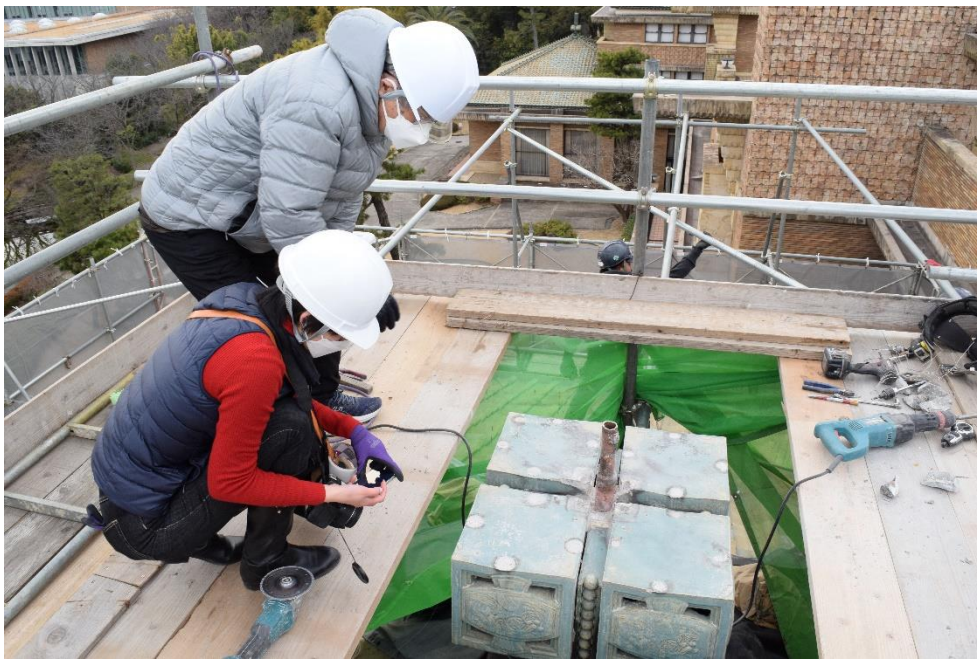
棟飾りの取り外し作業
