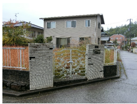
空地化した公園横の宅地
