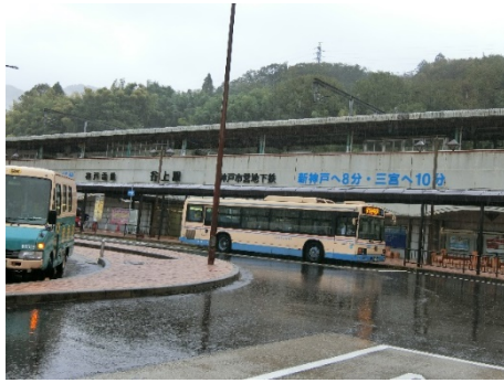
神戸市営地下鉄 谷上駅
