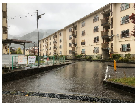
ロータリーを北方向に進んだ市営住宅
