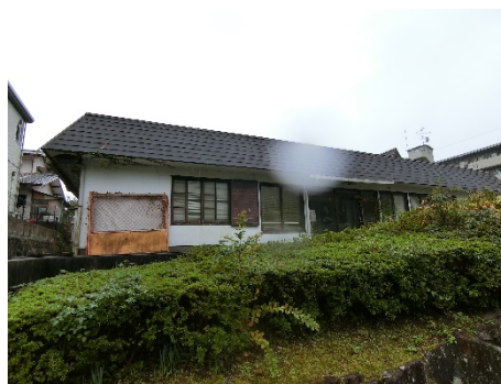
廃屋化した会館
