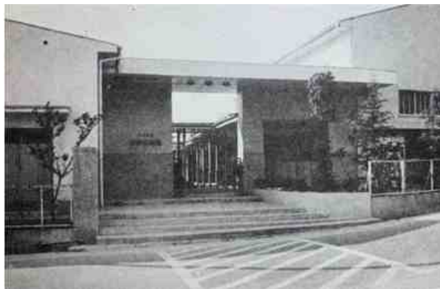
写真14 創設以来はじめての独立の新園舎
